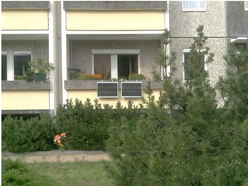
Abbildung 4.1.: Beispiel der Solarzellenmontage an einem Balkon.
