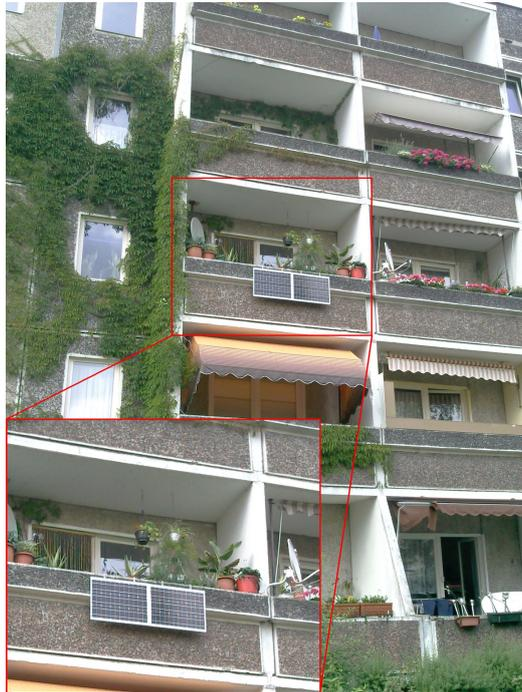
Abbildung 4.3.: Weitere Möglichkeit der Solarzellemontage, setzt die Zustimmung des Vermieters voraus.
